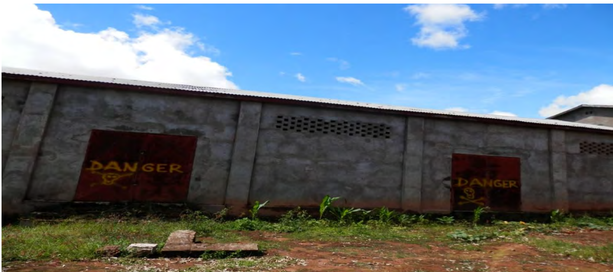
Bâtiment de stockage temporaire de déchets des sols souillés par les produits phytosanitaires après l'incendie de l'Hoechst
