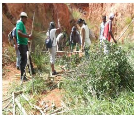
Formation stabilisation Lavaka
