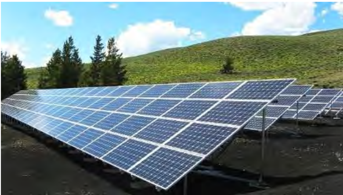
Grande centrale solaire par la Société Green Yellow à Ambatolampy (20MW d'électricité renouvelable pour alimenter 50000 foyers
