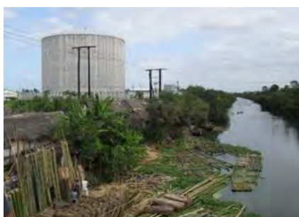
Réservoir d'ammoniac pur sur les berges du Pangalana (Maharavo, 2016)
