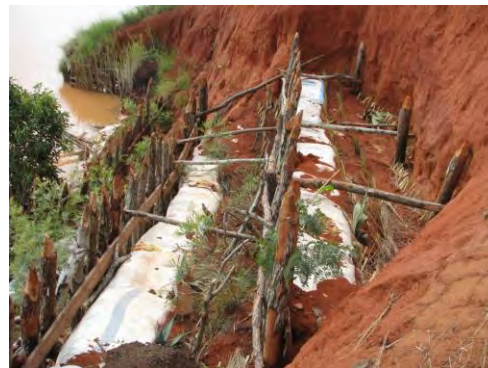
Réalisations en matière de protection de berge et talus photo
