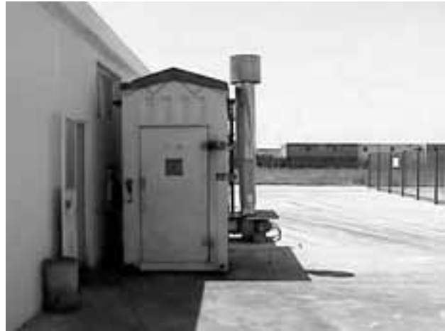
Cette petite salle d'injection de gaz en Tunisie possède une seule cheminée d'évacuation mais deux vitesses d'extraction
