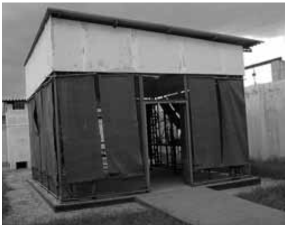
Exemple # 1: Une salle d'injection de gaz à ciel ouvert trop petite.
