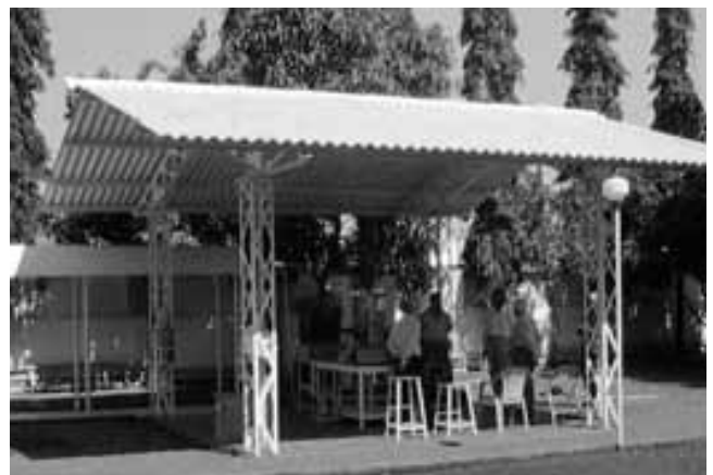
Exemple # 2: Une installation d'injection de gaz entièrement à ciel ouvert.
