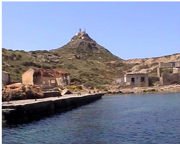
Figure 4 : habitations estivales du port fortement dégradées
