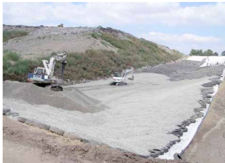
Fig. 34: Barrière géologique artificielle d'une décharge
