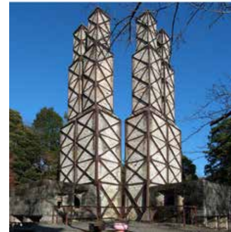
Fig. 23: Exemple de four à réverbère 28
