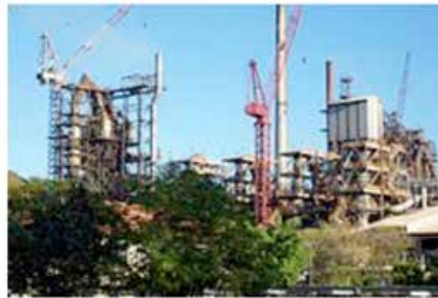
Fig. 26: Exemple de four ISA Smelt 31 .
