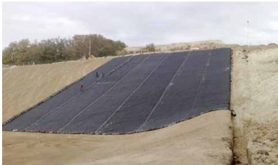
Fig. 35: Barrière artificielle utilisant l'isolation HDPE
