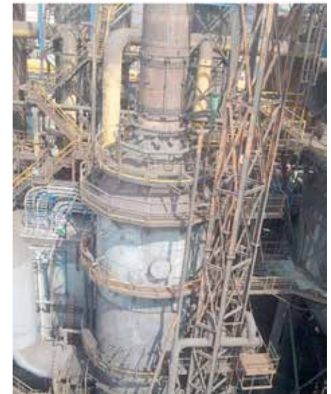
Fig. 24: Exemple de haut fourneau 29
