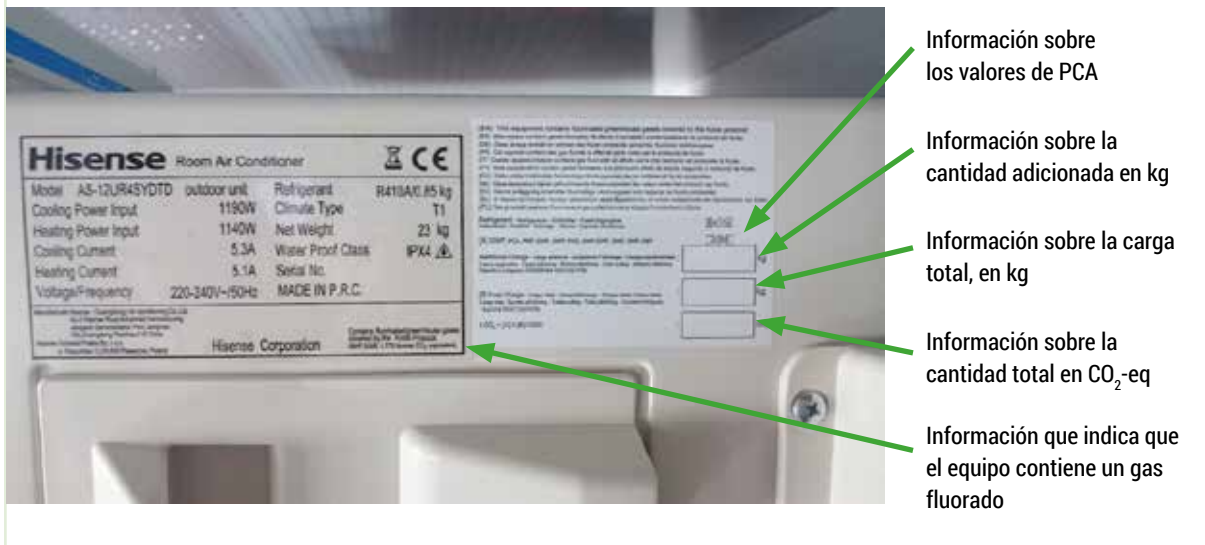
Fig. 7. Ejemplo de etiquetado del equipo que contiene a los HFC de conformidad con los requisitos de la UE (cortesía de la Fundación PROZON de Polonia)
