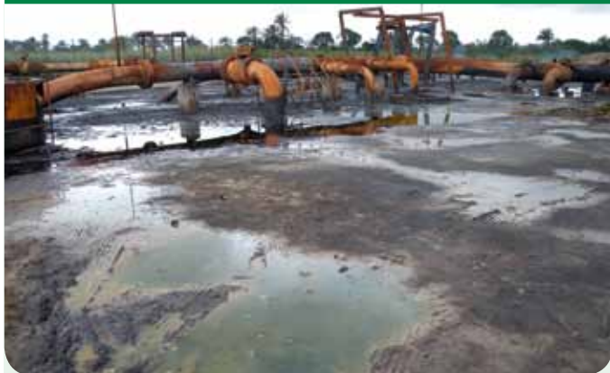
Contaminación por petróleo en la estación de bombeo de Bomu en K-Dere, Ogoniland (Nigeria). Foto: PNUMA.
