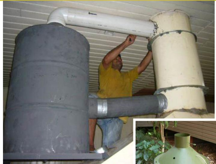
Arriba: El Sistema de Colectar Mercurio (SCM), instalado en una tienda de oro en Peru, puede reducir emisiones de mercurio por ~ 80%. Derecha: Un prototipo del SCM antes de ser probado en el campo por la APA y el Laboratorio Nacional de Argonne.
