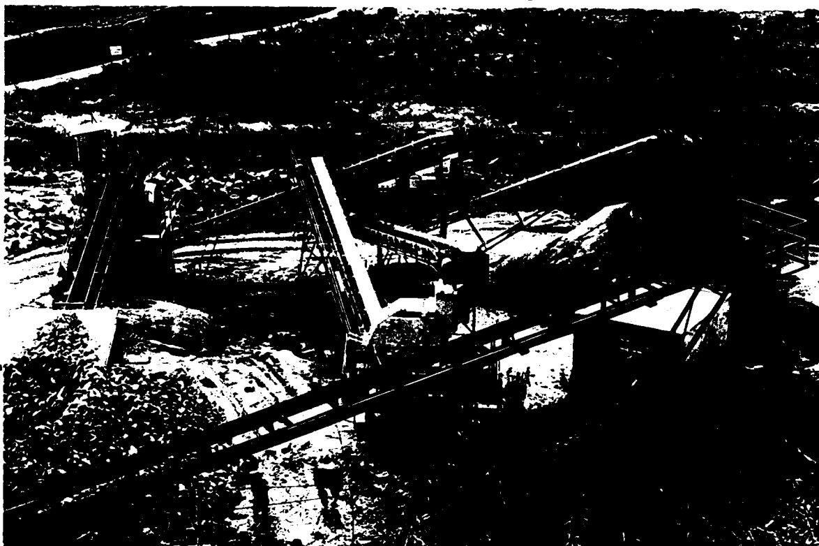
Photo 26 - Installation (U.B.P.) de concassage des blocs basaltiques
