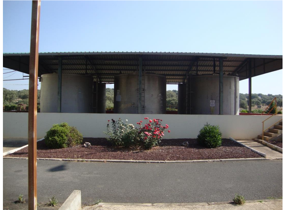
Facilities mercury storage «Las Cuevas» (Almadén)
