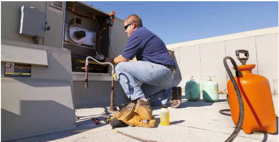
Figure 7 : Entretien d'un système de toit
