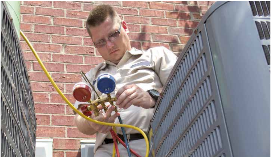
Figure 5 : Charge d'un système de climatisation avec du HCFC-22
