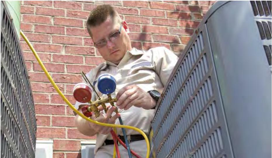
Figura 5: Carga de HCFC-22 en un sistema de aire acondicionado
