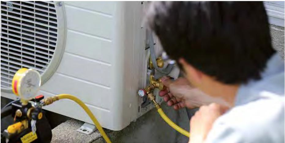
Figura 6: Cambio de refrigerante en una unidad de aire acondicionado
