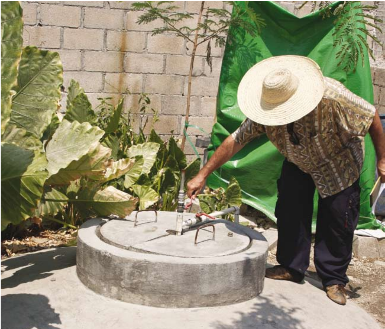
Du biogaz brûlant dans un petit biodigester relié à des toilettes propres et fournissant du gaz pour la cuisine à la communauté environnante, à Bel Air, Port-au-Prince
