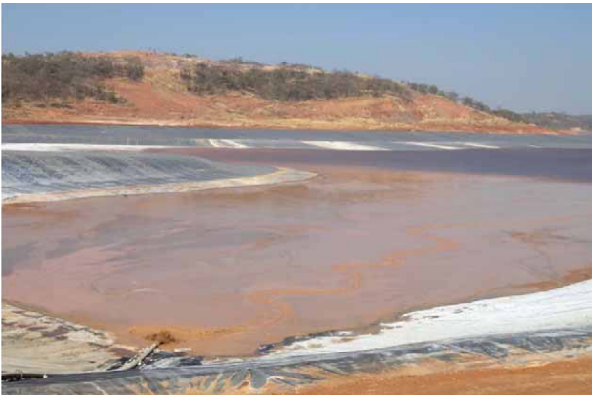
La société Tenke Fungurume a installé une infrastructure moderne de stockage des rejets miniers équipée d'un revêtement synthétique de haute qualité pour contrôler la pollution des eaux souterraines – une première au Katanga et en RDC
