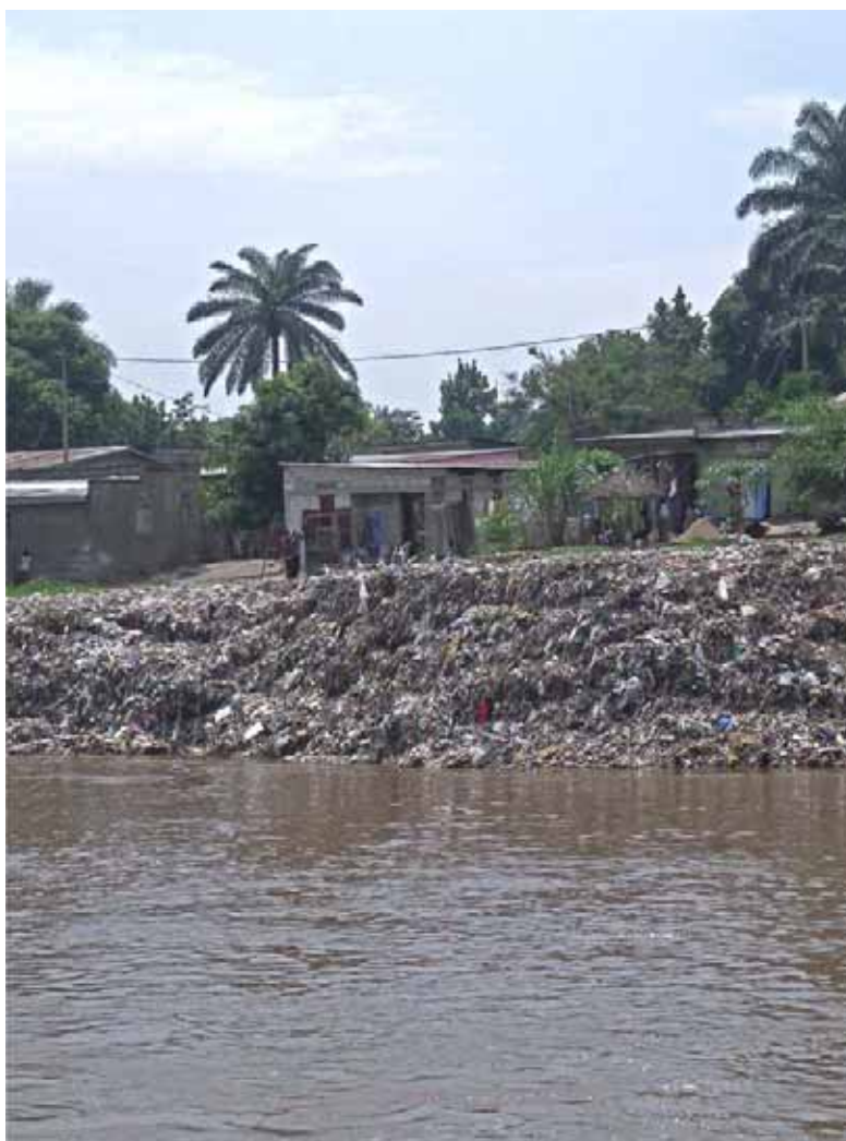
Les décharges situées le long des berges constituent des risques de pollution élevés pour les cours et les plans d'eaux
