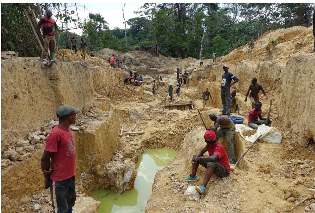
Photo 16 : Les mines à ciel ouvert ne peuvent fonctionner que lorsque l'eau est pompée et que les parois des cuvettes sont stabilisées. Cela impose des limites à la profondeur de l'exploitation et élargit la zone qui doit être défrichée pour maintenir le même nombre de mineurs au fil du temps. Les fosses sont creusées avec des outils à main et l'eau est enlevée avec des pompes à essence
