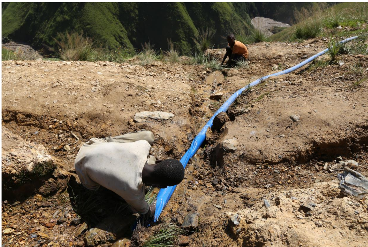
Photo 29 : Les tuyaux sont parfois utilisés pour fournir de l'eau pour les opérations de traitement sur place ; un défi majeur et un coût pour les mineurs
