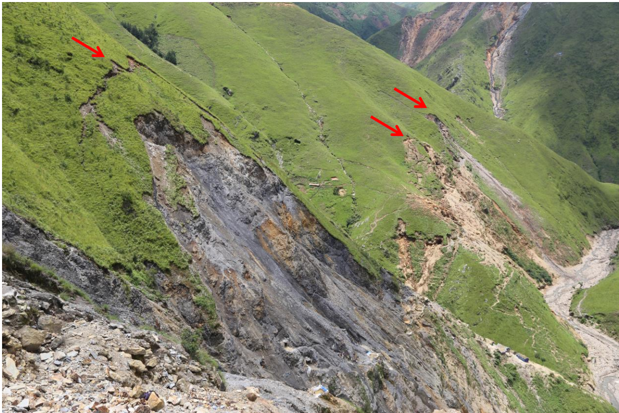
Photo 27 : Les fissures visibles sur les pentes de montagne en haut à gauche et à droite de cette image sont un signal alarmant d'effondrement imminent
