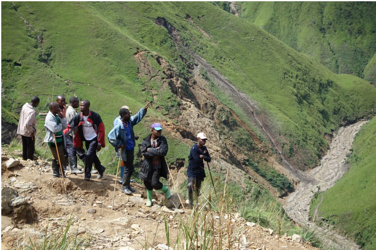
Photo 7 : Remarquez la trame de fissures dans la mine de cuivre sur la pente adjacente, et le déversement de déchets de roche grise s'étendant à mi-chemin au travers du lit de la rivière. Les chemins sinueux créés par les canaux muraux construits par les mineurs alluvionnaires peuvent également être distingués ci-dessous.
