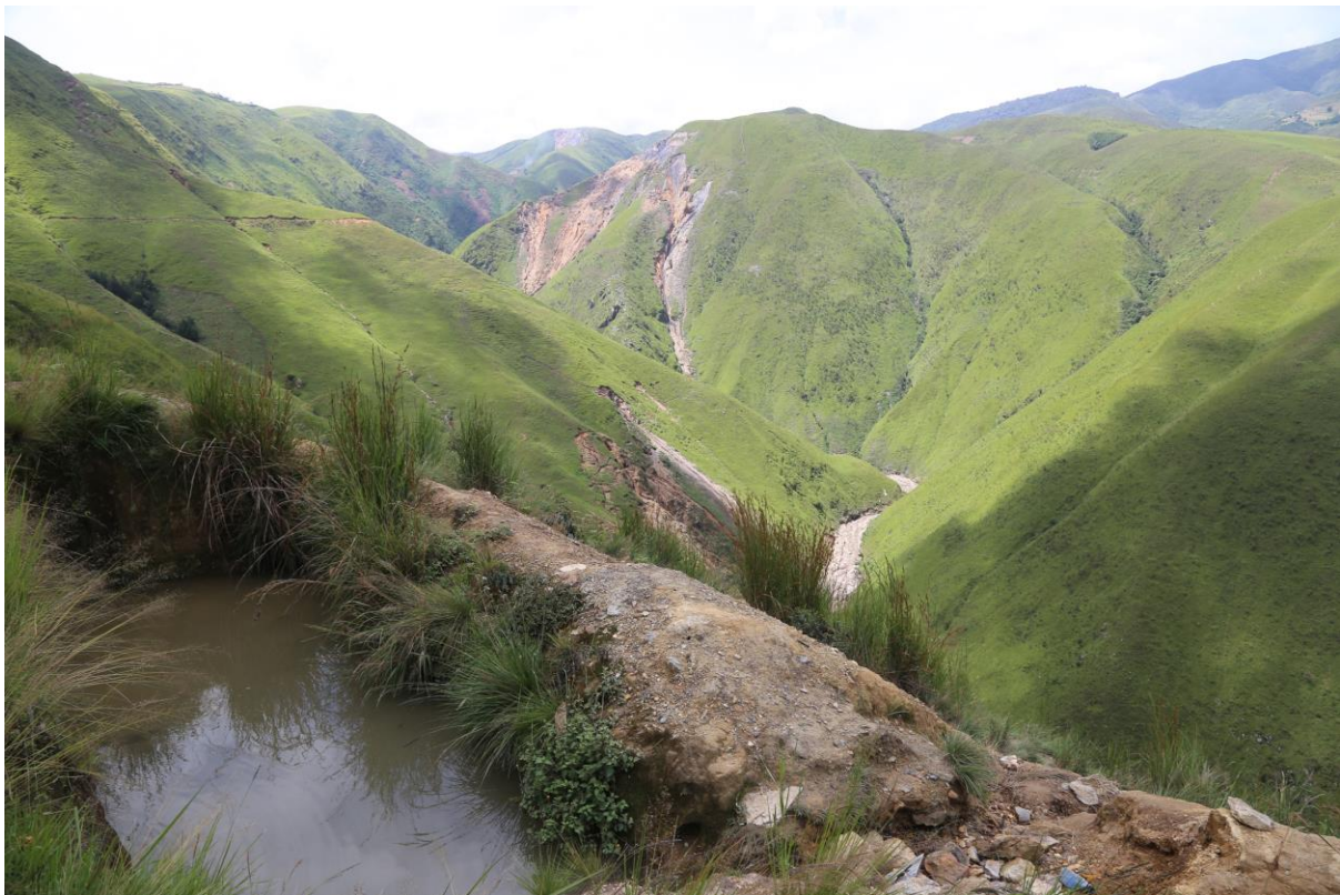
Photo 28 : Les puits de collecte d'eau situés au-dessus du site minier de Butuzi augmentent l'infiltration dans les zones d'initiation des glissements de terrain
