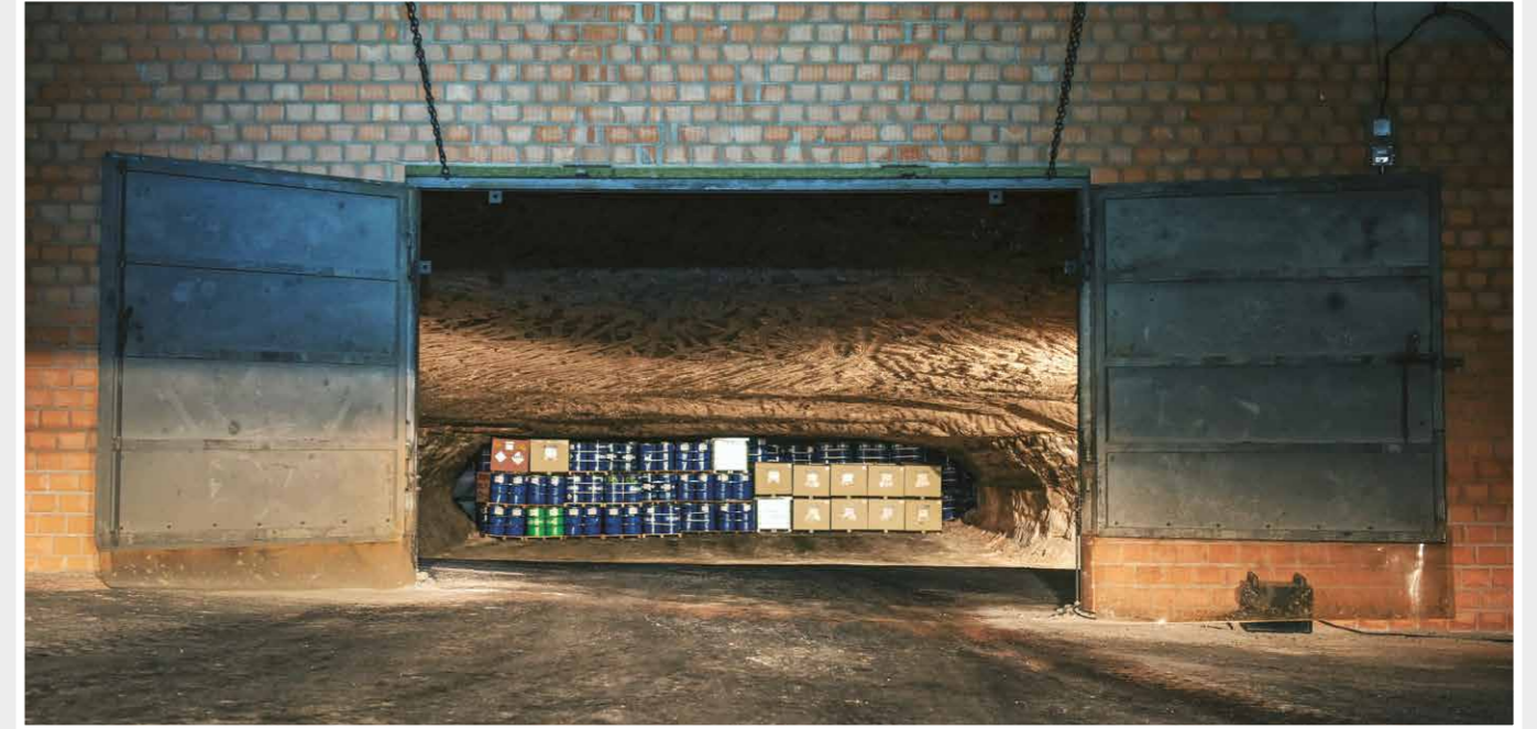
حجرة للتخلّص من النفايات الملوّثة بالزئبق في منشأة تحت الأرض © شركة كيه + إس إنتسورغونغ المحدودة
