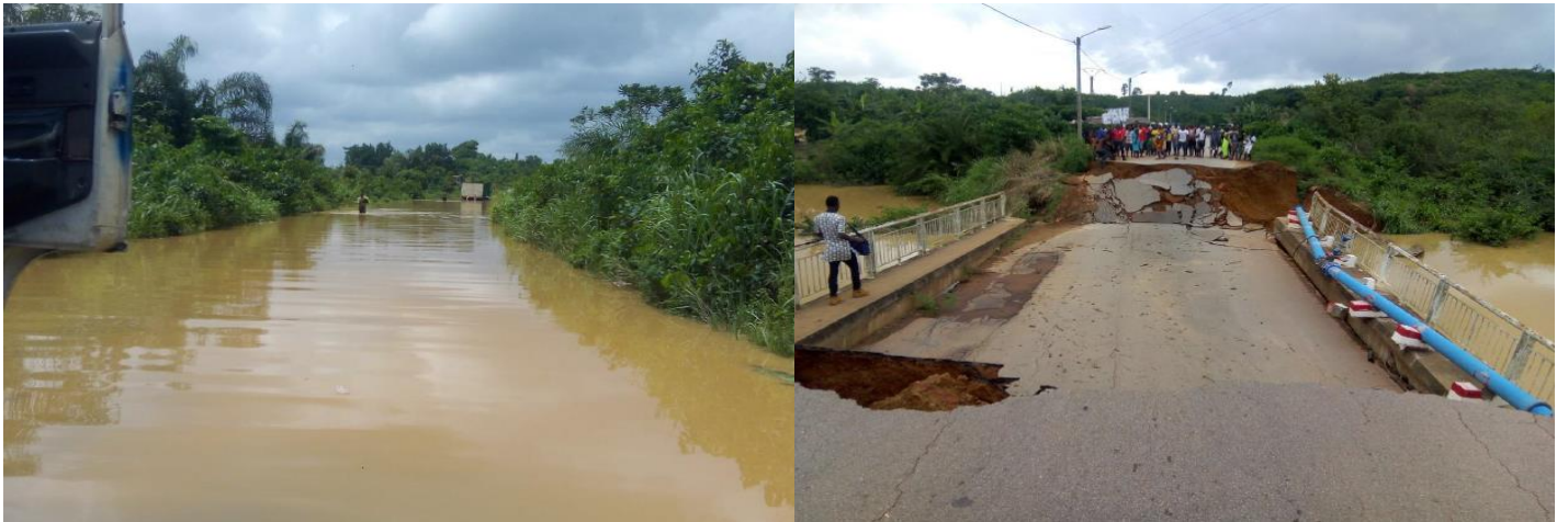
Figure 14 : Conséquences des inondations sur la voirie à San-Pédro. Gauche: La route côtière à 10 km de San-Pédro (village Pont-Brimé), en juin 2017 ; Droite : Pont de Digboué au corridor ouest, route de Tabou, San-Pédro. Source : Ministère de la Salubrité, de l'Environnement et du Développement Durable
