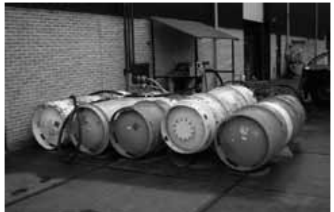
Фото 6-20. Герметичные баллоны вместимостью в 1 тонну (1000 кг).
