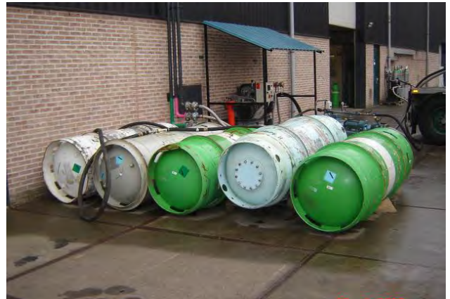
Foto 6-20 - Cilindros presurizados con una capacidad de 1 tonelada (1000 kg)
