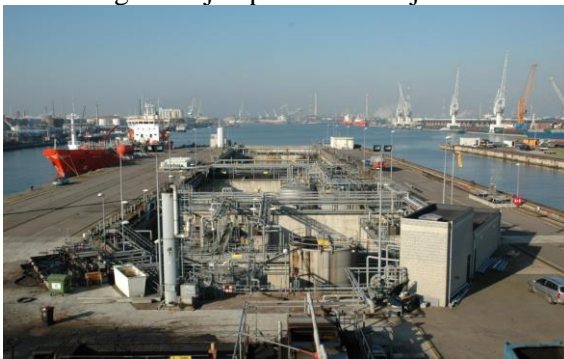
Instalación fija de recepción y tratamiento (Foto:
