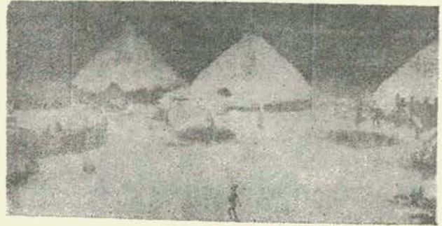
اسقف المساكن مصنوعة على هيئة مخروط من النباتات لعزل الحرارة واتقاء هطول الأمطار .
