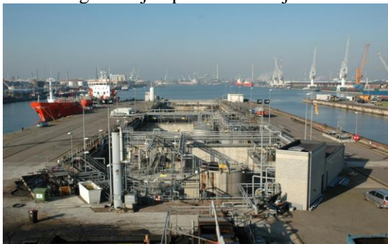
Instalación fija de recepción y tratamiento (Foto:
