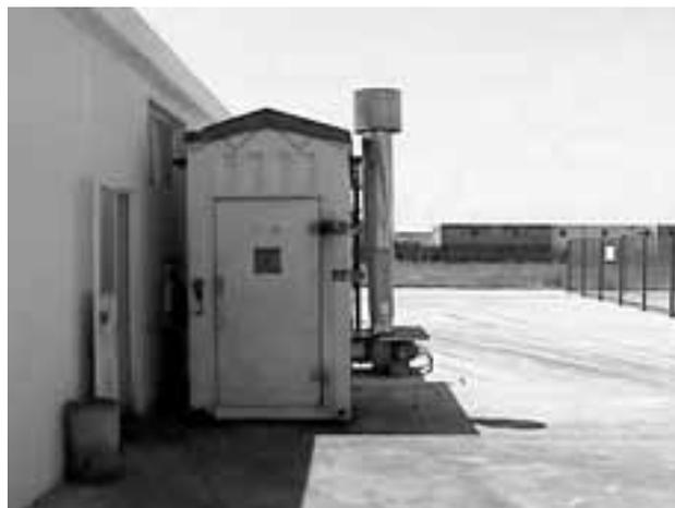
Esta pequeña sala de gaseado en Túnez sólo tiene una chimenea de escape, pero dos velocidades de extracción.
