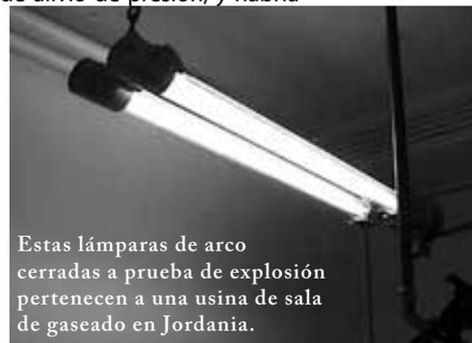
Estas lámparas de arco cerradas a prueba de explosión pertenecen a una usina de sala de gaseado en Jordania.
