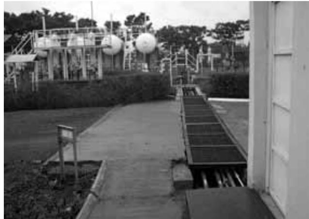
Esta excelente instalación en Tailandia muestra postes de protección, un buen cerco, y descarga paralela. Nótese la altura del “puente de caños”.
