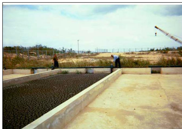
Fangos secos sobre lechos de secado hechos de hormigón.
