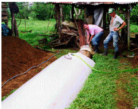
Instalación de un biodigestor
