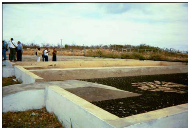
Fangos activados descartados en lechos de secado
