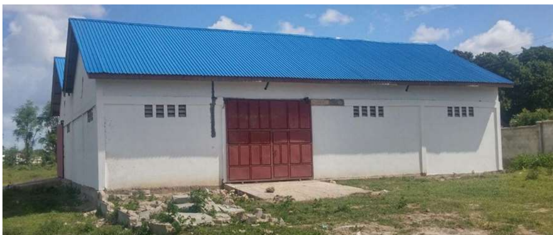
Figure 7 : BAPU dans un hangar de stockage couvert en Tanzanie.
