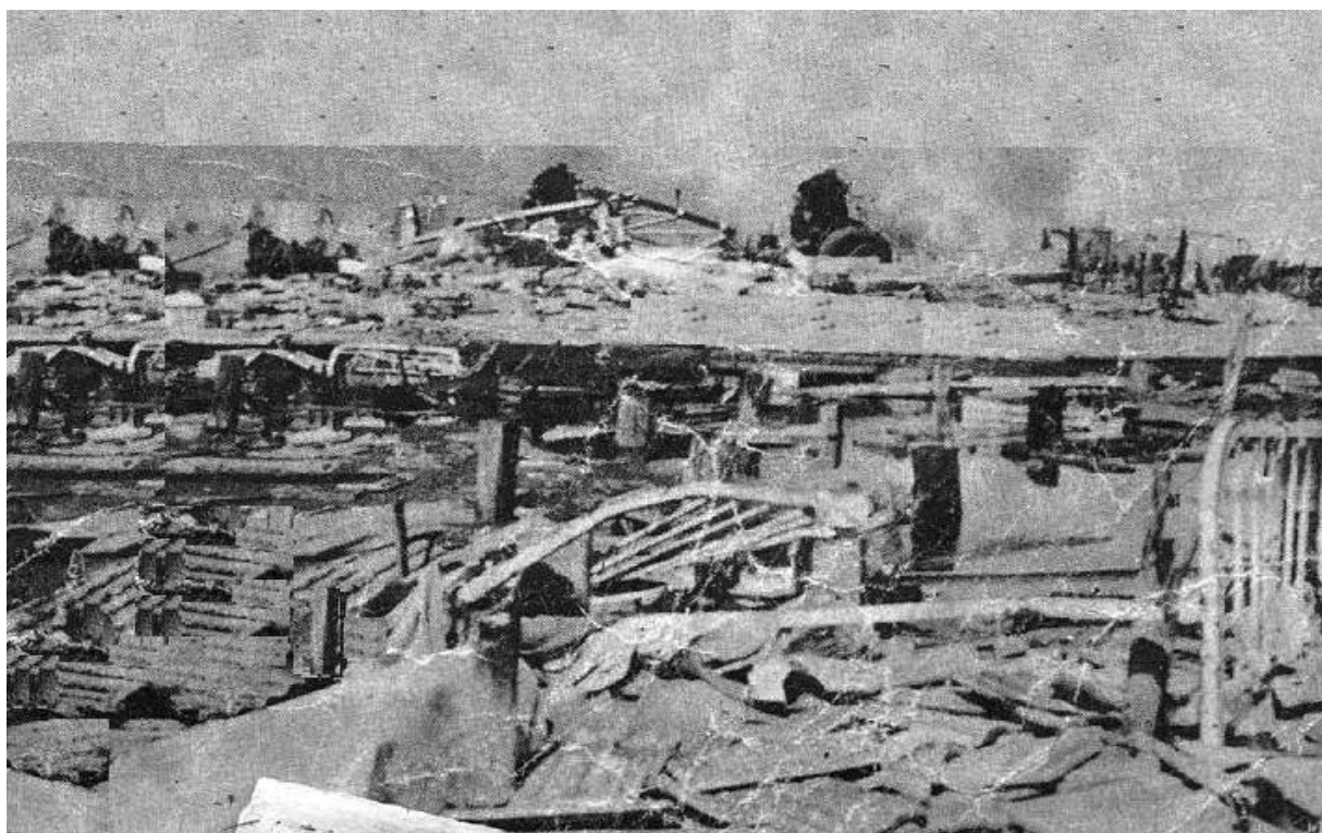
Figura 8. Derrumbes en Santa Cruz del Sur tras el impacto del huracán de 1932
