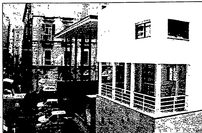
Naples Intégration d'équipements moderne dans le tissu ancien
