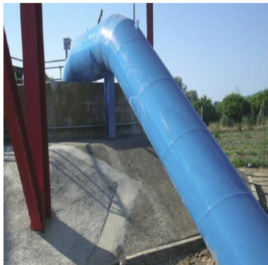
Un des puits construits pour l'approvisionnement en eau potable dans les villes en aval en cas d'urgence
