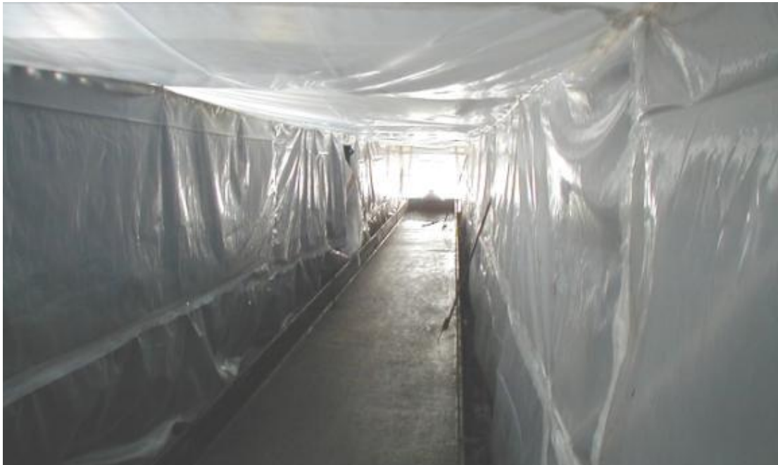
حبس الخلايا (متصل بوحدة معالجة الهواء)
