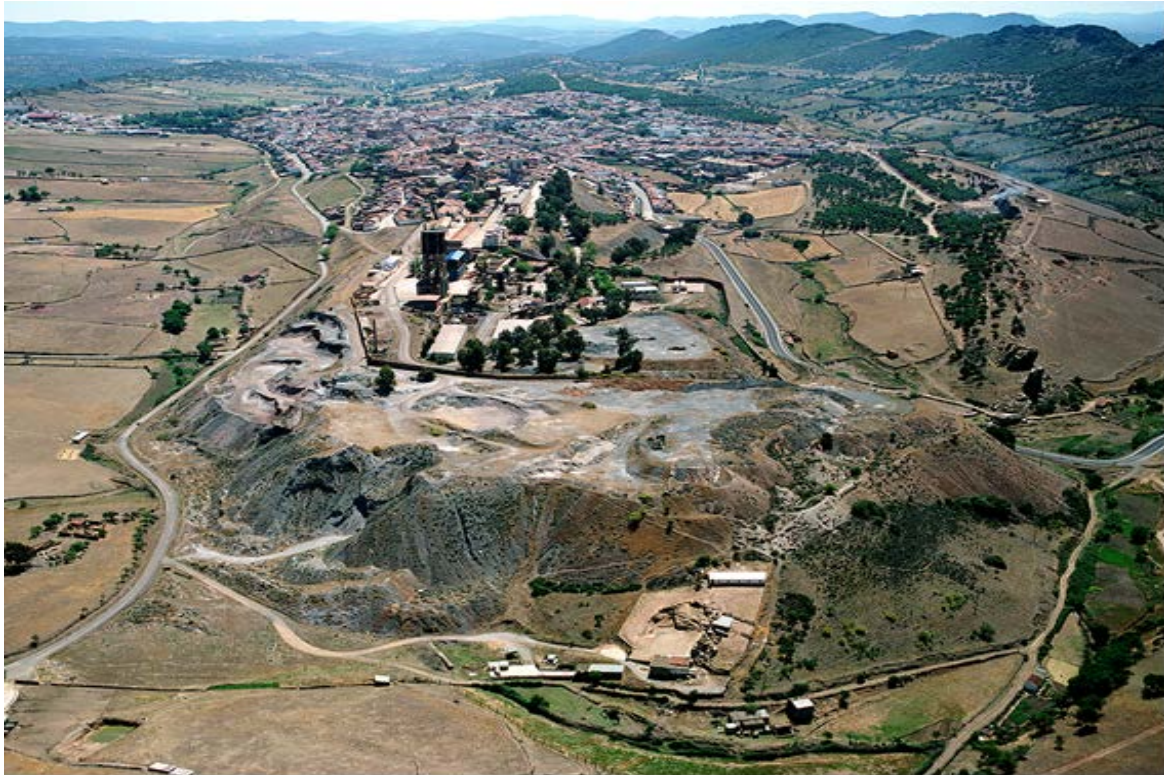
ركام خبث "CERCO SAN TEODORO". أيار/مايو 2005. صورة بواسطة موقع Paisajes Españoles
