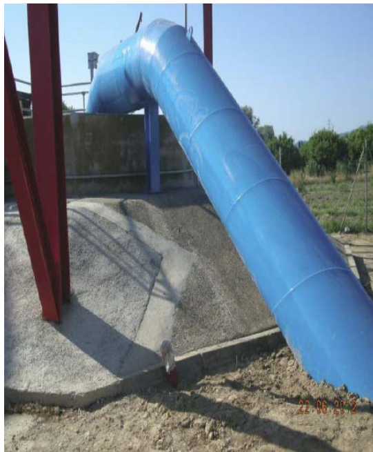
Uno de los pozos construidos para el abastecimiento de agua potable a las poblaciones situadas aguas abajo en caso de emergencia
