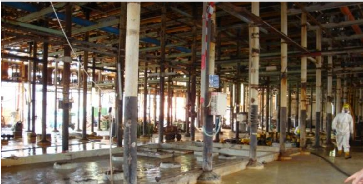
Suelo de la sala de celdas lavada periódicamente
