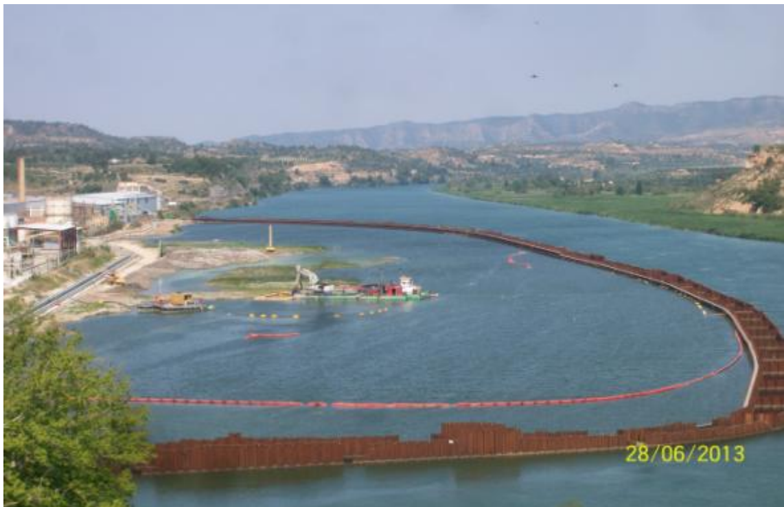
Actividades de dragado dentro del muro de tablestacas
