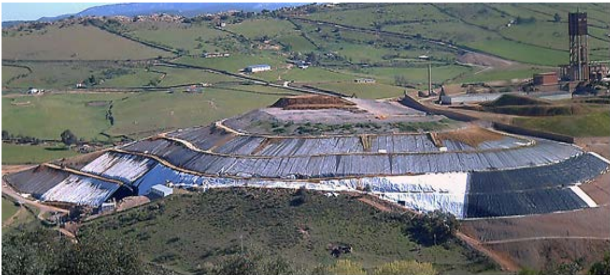
ESCOMBRERA DEL CERCO DE SAN TEODORO, MARZO DE 2007.
