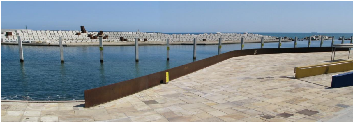
Figure 10 : Structure artificielle de forme paysagère (Parc dels Auditoris, Barcelone, A. Mlakar)
