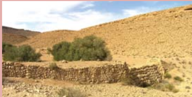
Construcción de terrazas para recuperar el agua y controlar el corrientes laminar sobre la tierra cerca de Tataouine, en el sur de Túnez.
