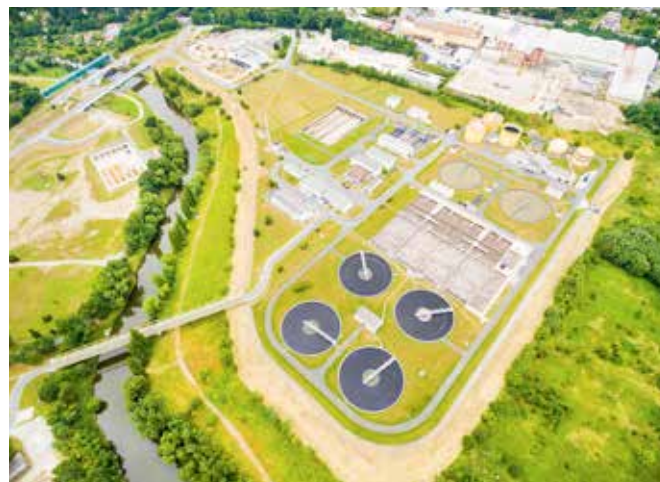
Городские очистные сооружения на 165 000 жителей, вид с воздуха; г. Пльзень, Чешская Республика
