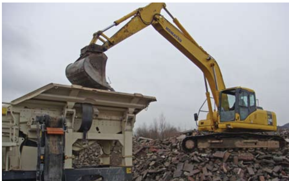
在四川省擂鼓镇所见到的地震摧毁的大量废墟
