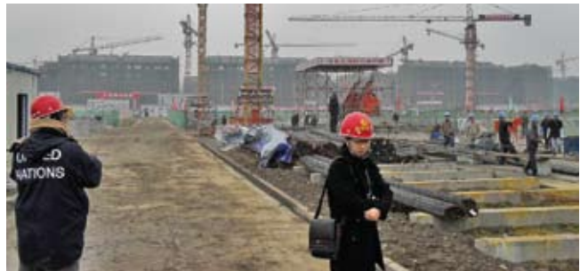
正在进行的重建过程结合了环境和减灾要素
