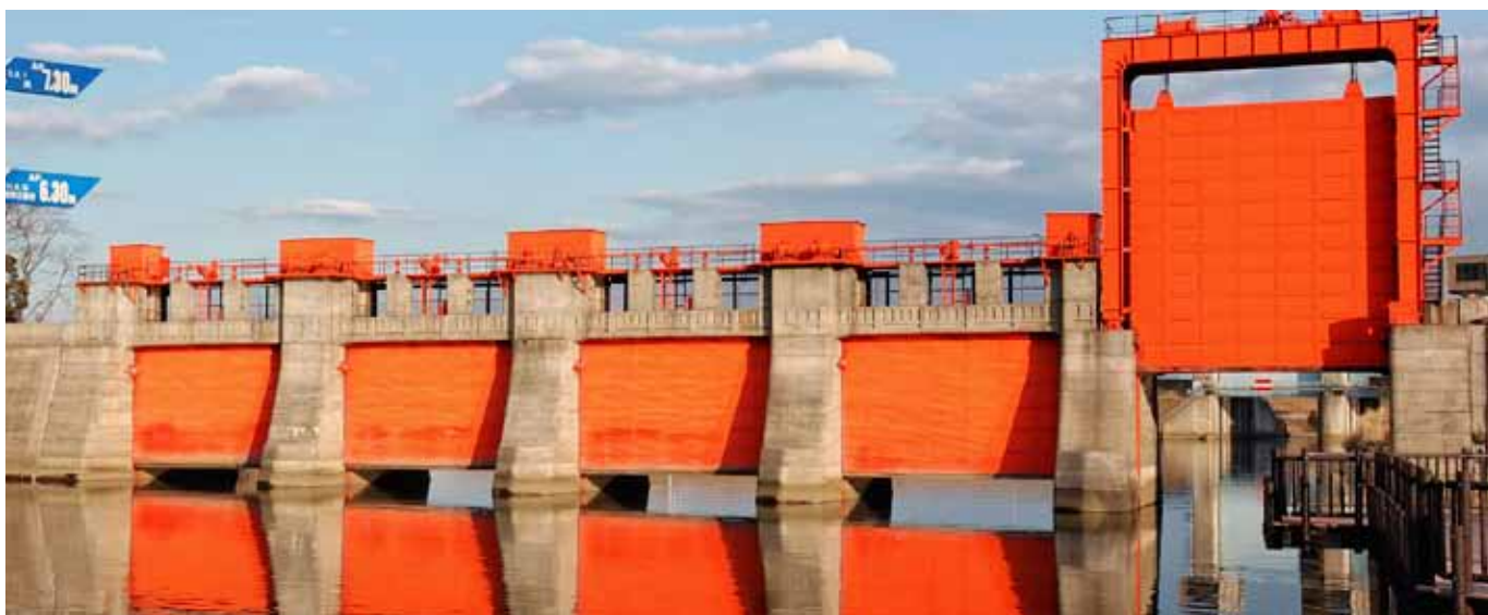
Исторический шлюз Ивабучи, Токио, остаётся крайне важным для общин, живущих вдоль двух быстро текущих, подверженных наводнениям рек Японии. © Juergen Sack
