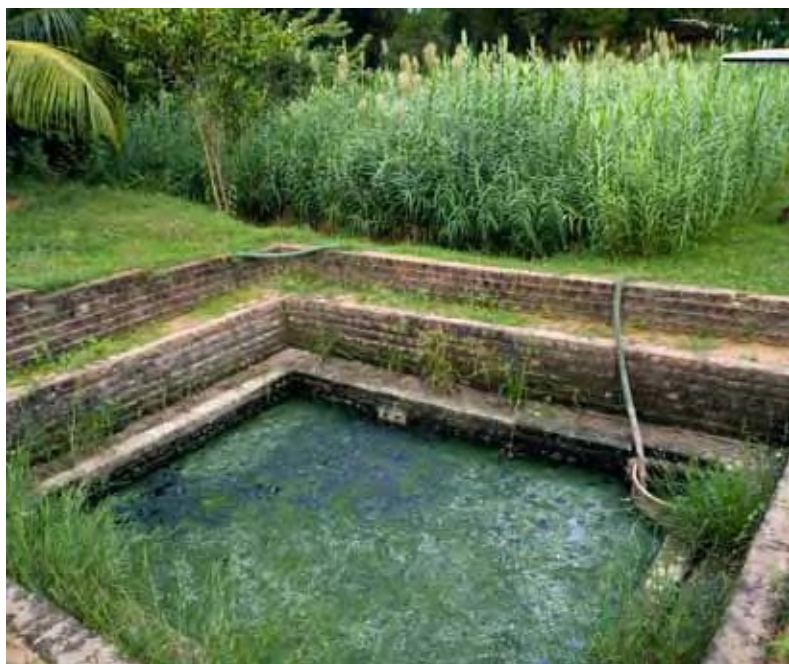
Децентрализованные системы очистки сточных вод в Наду, Индия, для небольших объёмов. © Chinch Gryniowicz/SpecialistStock
