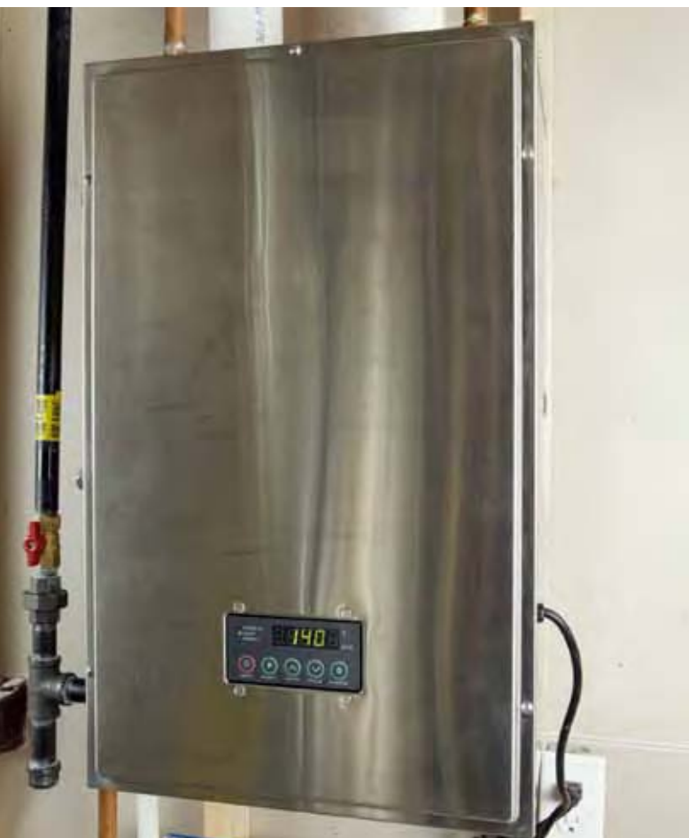
Бытовой конденсирующий гибридный безрезервуарный водонагреватель. Эта технология производит горячую воду по запросу и гораздо более энергоэффективна, чем обычный резервуар, содержащий горячую воду. © BanksPhotos/iStock
