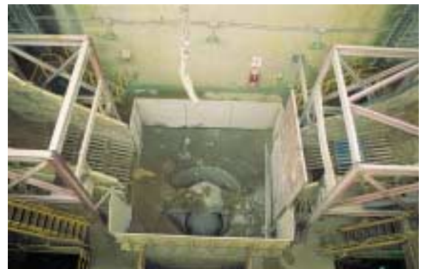
Cone crusher - Fosfertil, Brazil
