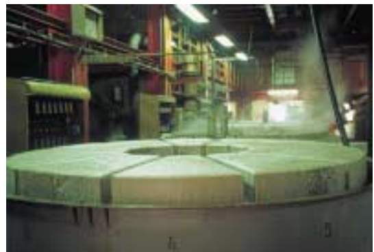
Pneumatic flotation cell - Kali und Salz GmbH, Germany
