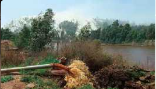
ウェストランド金鉱地 (ヨハネスブルグ) の砂捨場20: 手前のパイプから尾鉱 (選鉱くず) ダストと大量の酸性坑廃水 (AMD) を含む水が排出されることに注意
