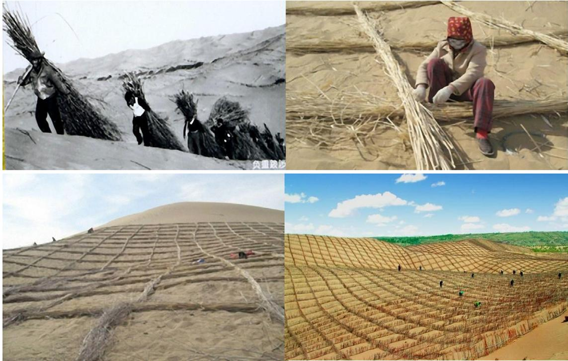
图 4.4 使用沙柳、秸秆等材料捆绑而成的网格沙障技术
