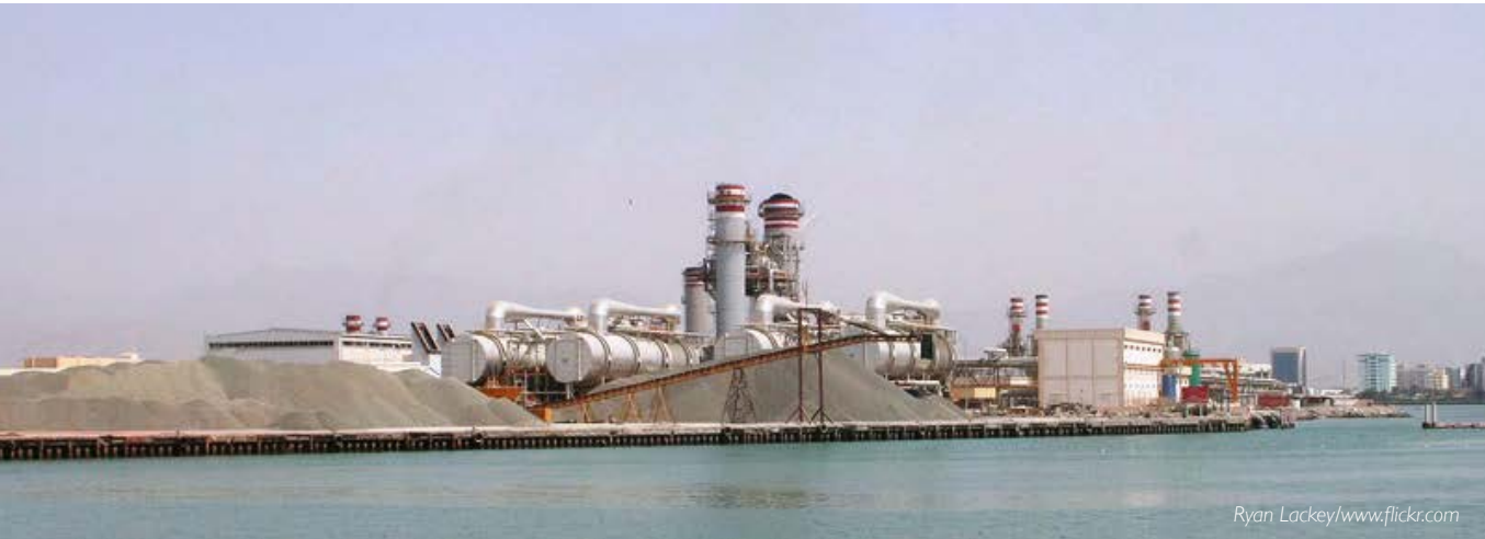
Desalination plant, Ras al-KAhaimah, U.A.E.
