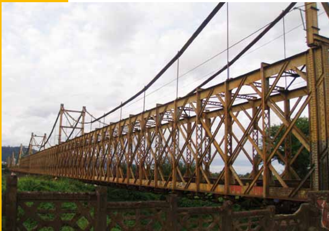
Puente sobre el rio Cautín, Temuco
