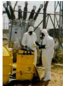
Photo 58 : Conditionnement de bouchons fuyants dans des fûts homologués ONU
