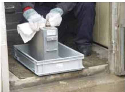
Photo 67 : Mise hors service et nettoyage d'un condensateur contenant des PCB
