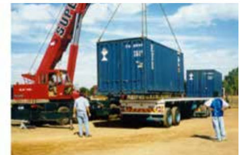
Photo 98 : Levage et positionnement des conteneurs sur la plateforme du camion
