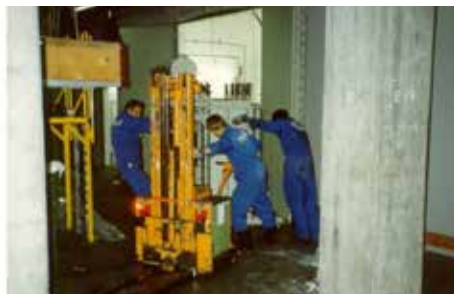
Photo 54 : Mise hors service d'un transformateur intact contenant des PCB
