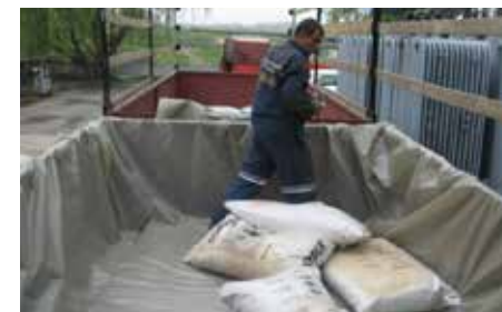
Photo 69 : Préparation du transport d'un transformateur contenant des PCB
