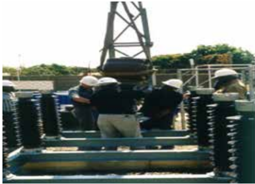
Photo 55 : Démontage d'une batterie de condensateurs
