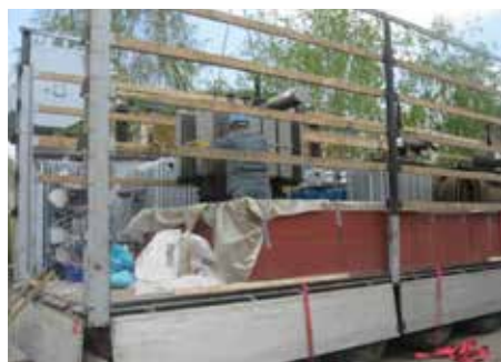
Photo 72 : Positionnement des transformateurs
