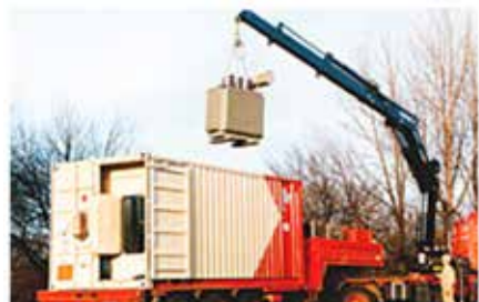
Photo 100 : Chargement de transformateurs
