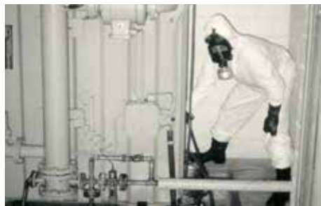
Photo 53 : Purge d'un transformateur contenant des PCB
