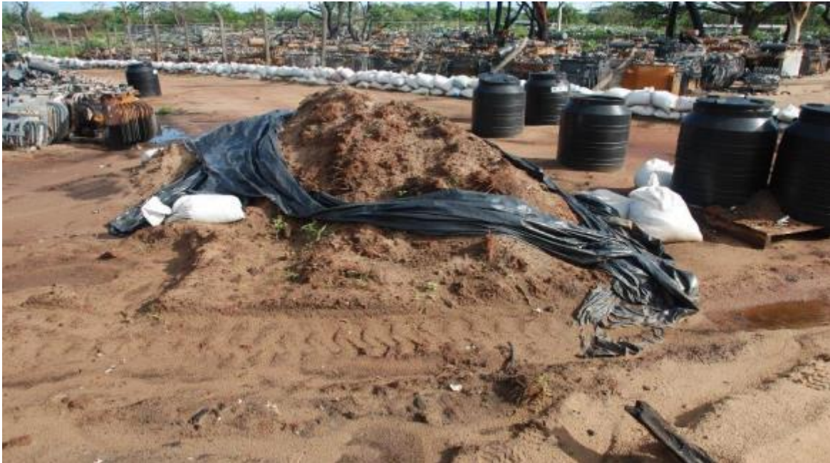
Imagen 12. Montones de arena utilizada para la contención y absorción de derrames.
