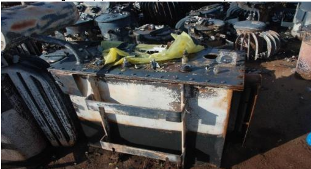
Imagen 6. Equipos abiertos expuestos a la intemperie.
