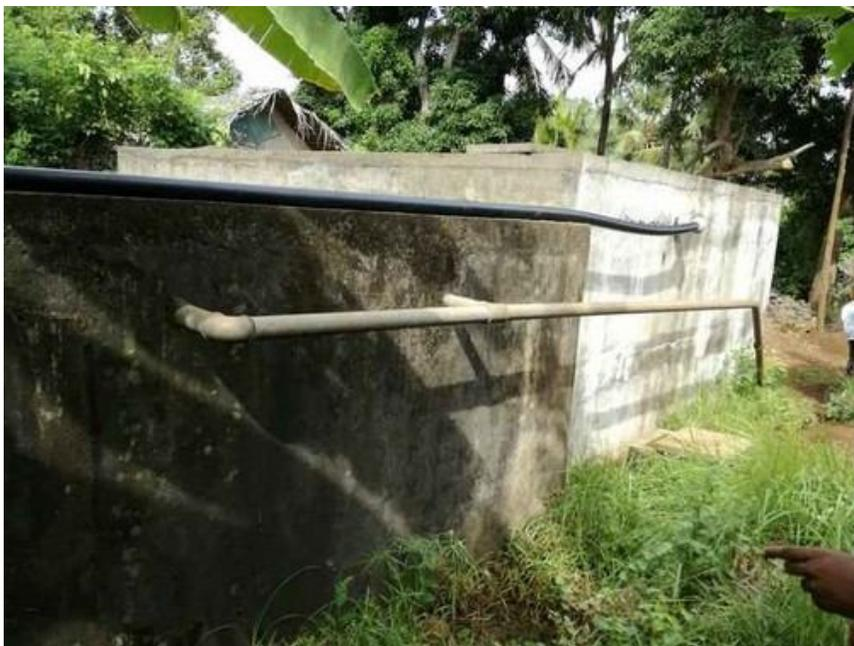
*L'alimentation en eau potable (AEP) à Lingoni-Mbatsé, le réservoir nouveau (à droite) et l'ancien (à gauche). Prennent en compte que les connections au réservoir nouveau ne sont pas nombreuses, il déborde dans l'ancien réservoir (tuyau supérieur nègre) et augmente la disponibilité en eau dans le système de distribution ancien.*
