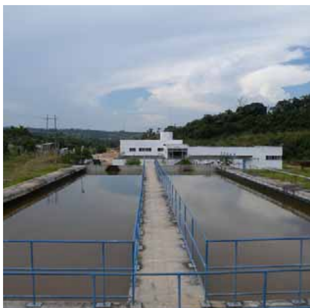
L'usine de traitement de l'eau à Kimwenza
