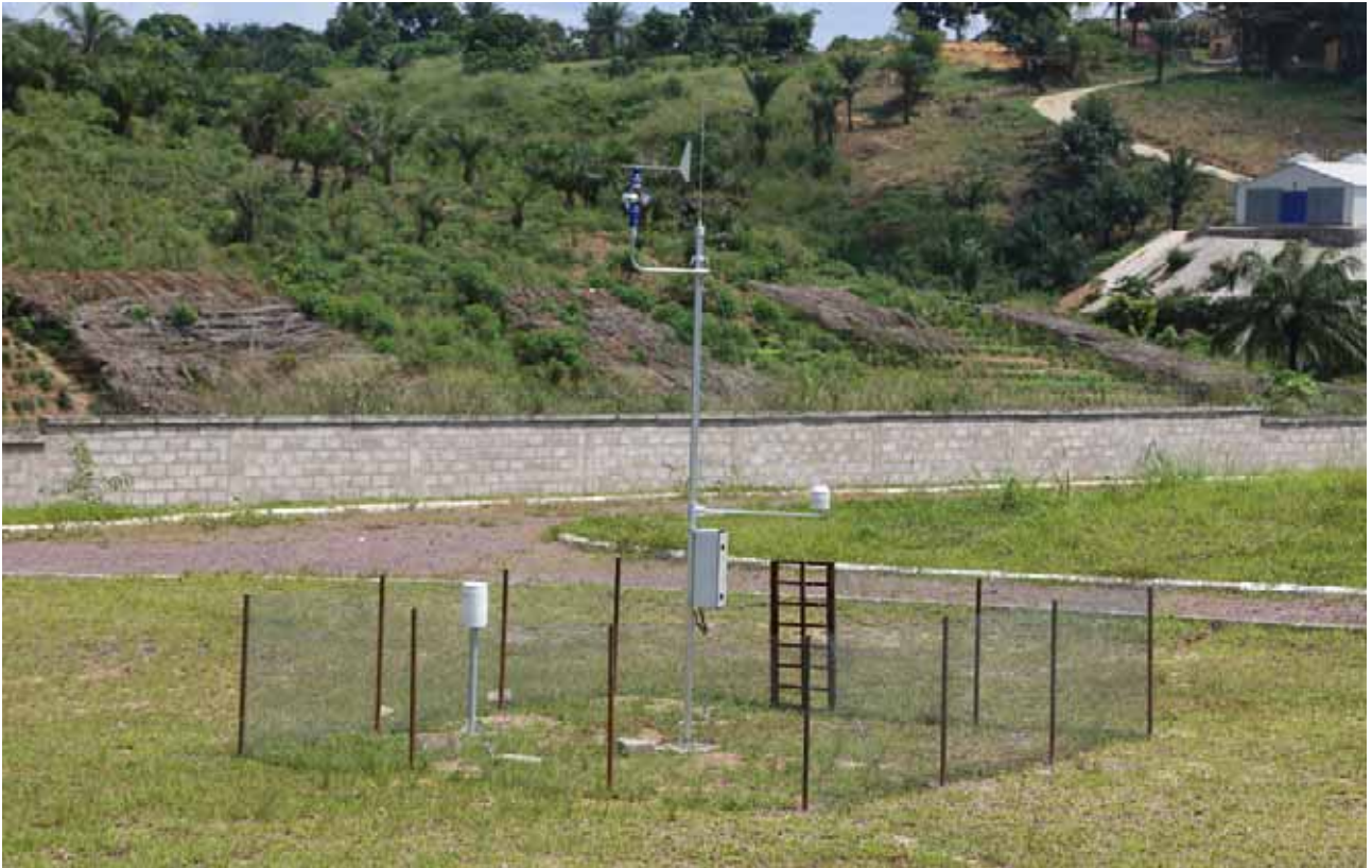
Installation d'une nouvelle station météorologique
