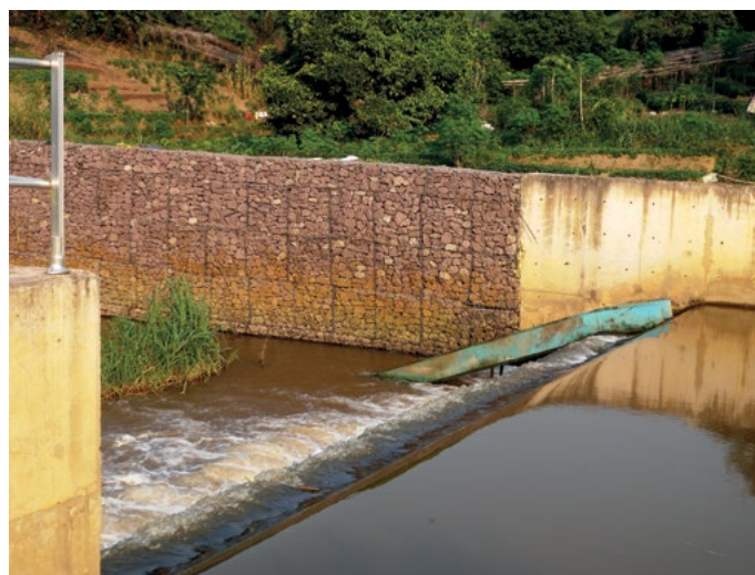
Photos 4. Conduite d'amenée d'eau de l'usine de la REGIDESO à Kimwenza : barrage et dessableur
