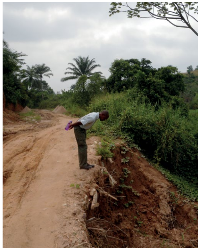
Photos 21. Etat des routes secondaires dans le bassin versant de la Lukaya
