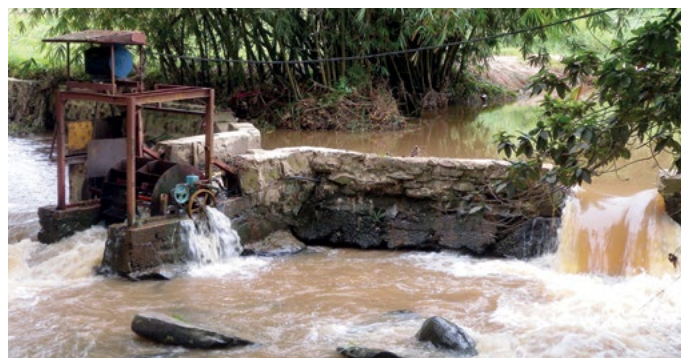
Photo 7. Pico barrage hydroélectrique du site Bikeko Beach à Kasangulu
