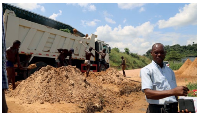
Photo 9. Extracteurs artisanaux du sable dans la partie aval du bassin
