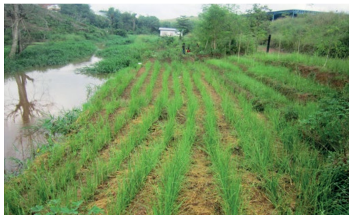
Stabilisation des berges de la rivière Lukaya en amont du captage de la REGIDESO à Kimwenza
