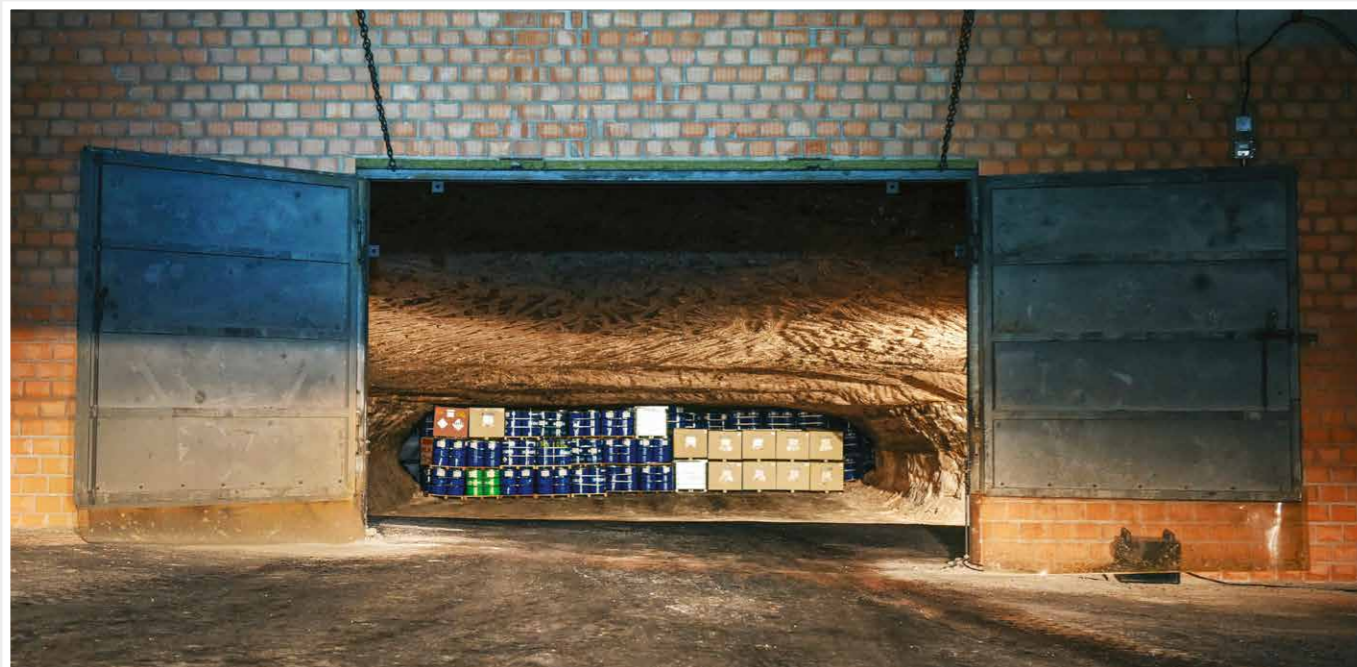
Cámara de eliminación de desechos contaminados con mercurio en una instalación subterránea © K+S Entsorgung GmbH
