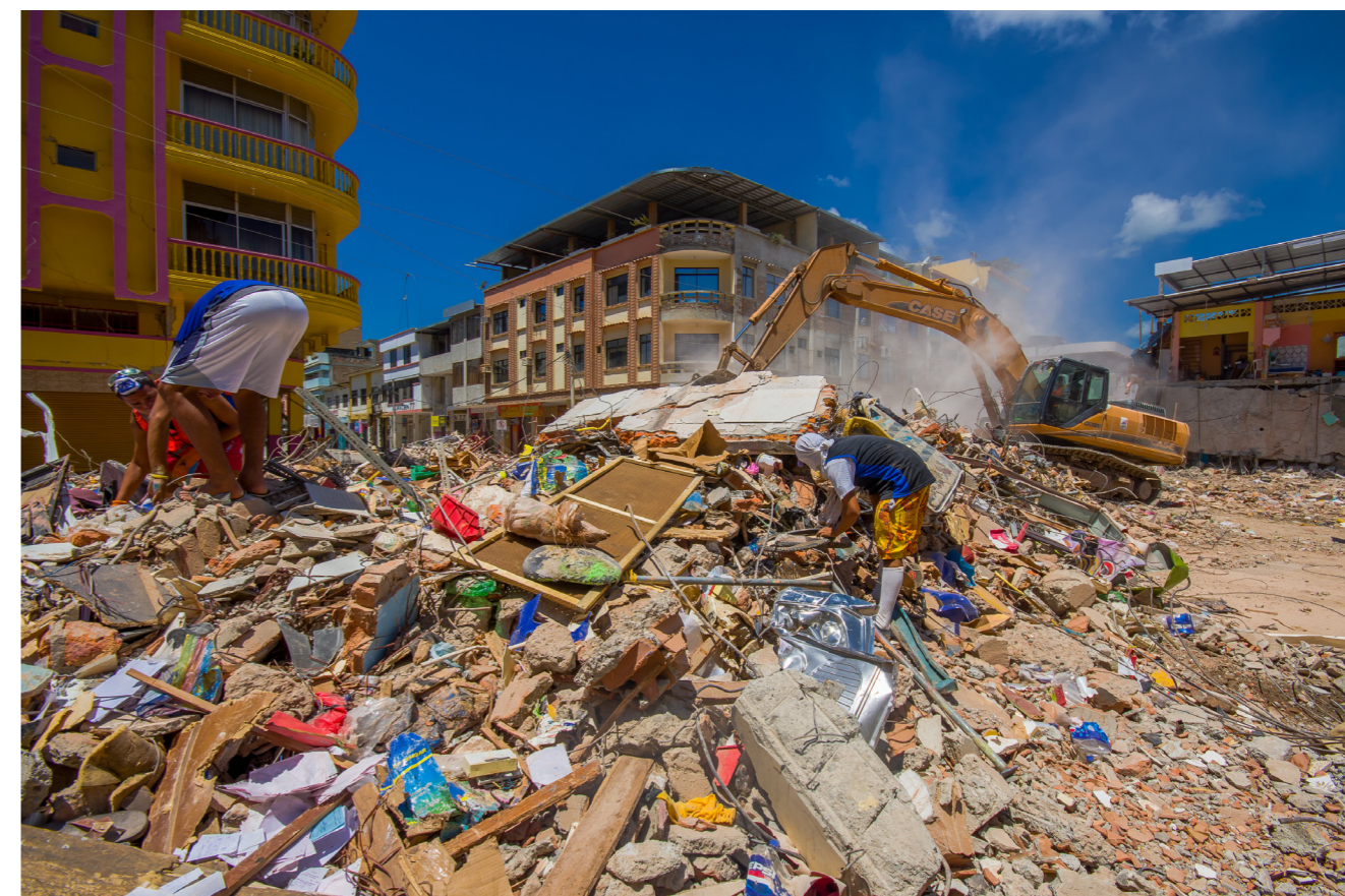
Remoción de escombros tras el terremoto. Portoviejo, Ecuador.
