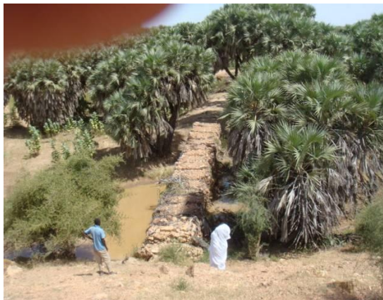
Photo 10. Ancien barrage artisanal au niveau de l'oued Niakhlée (populations).
