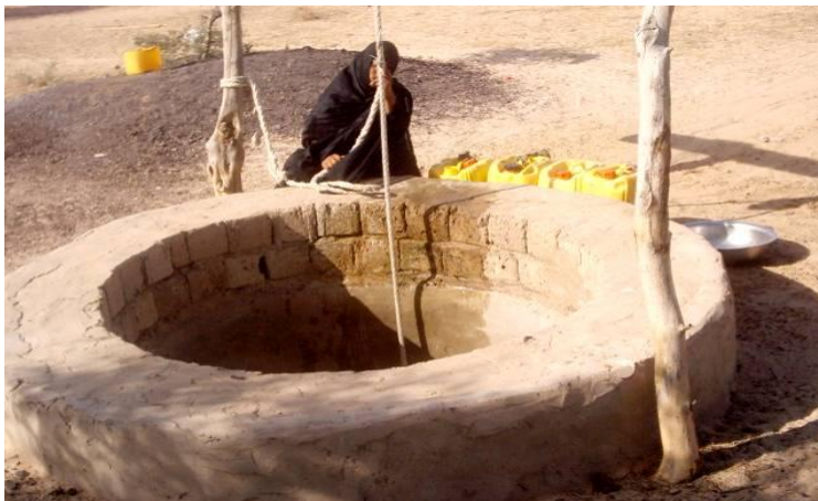
Photo 5. Puits à traction manuelle à Ehl Oumar (Dveia).
