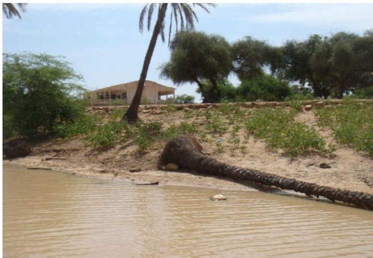
Photo 6. Érosion des berges de la rive est au voisinage de l'IFAC.
