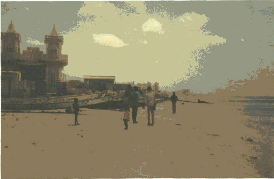
Fig. 3.12. - Constructions sur le haut estran à Rufisque (Sénégal) (Quélenec, 1984).
