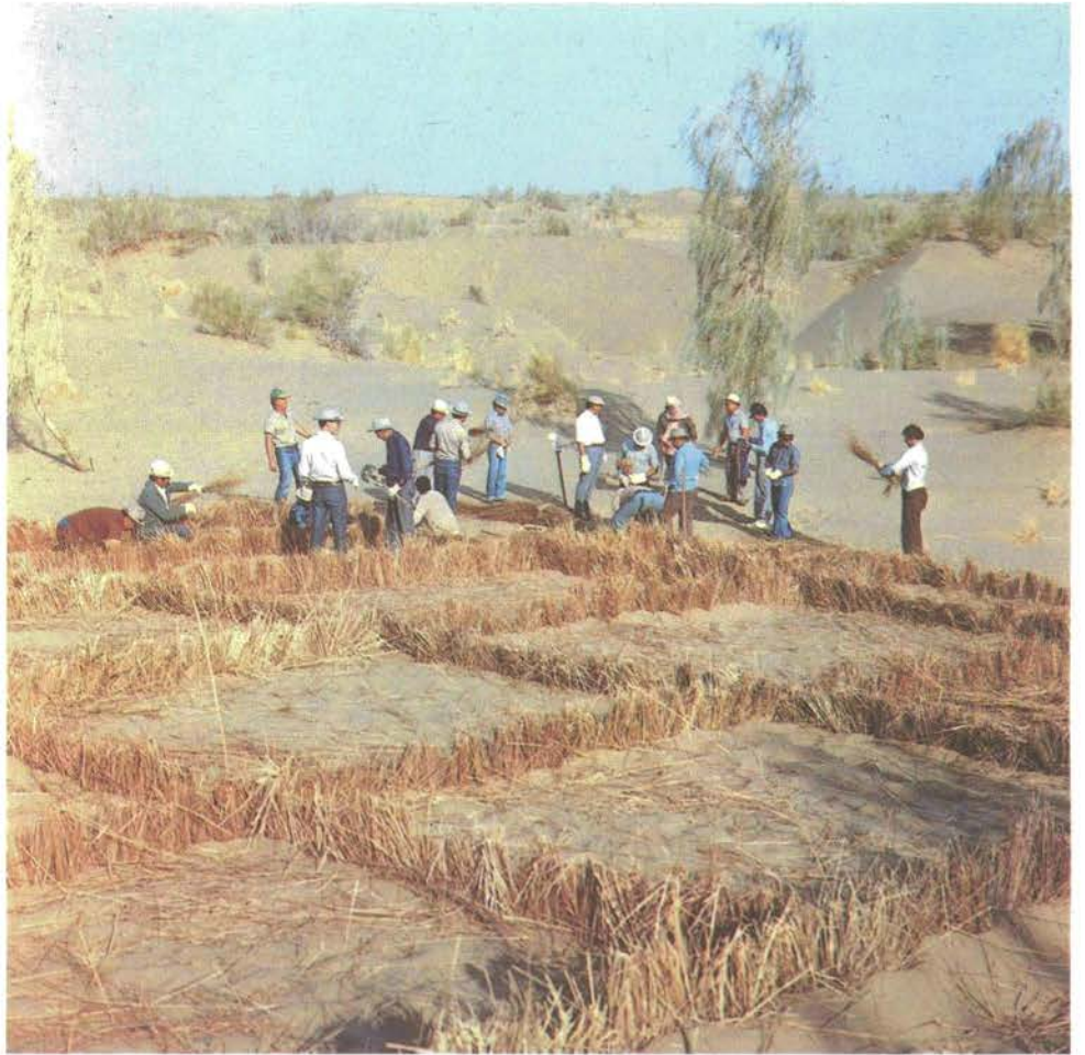
Cours pratique d'aménagement de défenses «à damier» pour les participants du stage international PNUE/URSS sur la lutte contre la désertification
