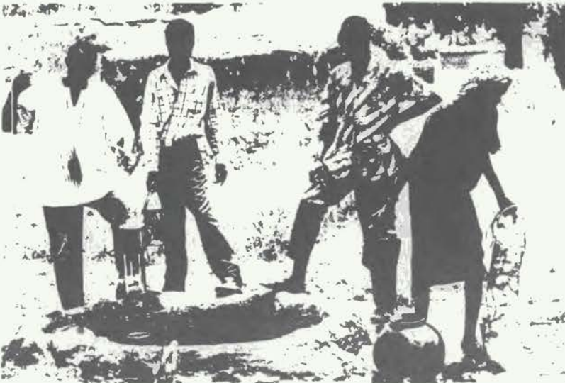
Échantillonnage avec la bouteille de prélèvement en vue d'analyses bactériologiques et chimiques
