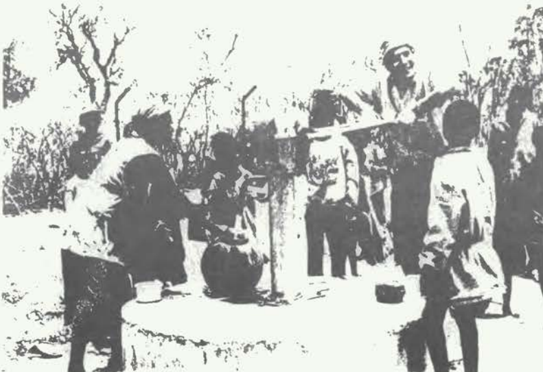
Puisage de l'eau d'un forage avec la pompe manuelle
